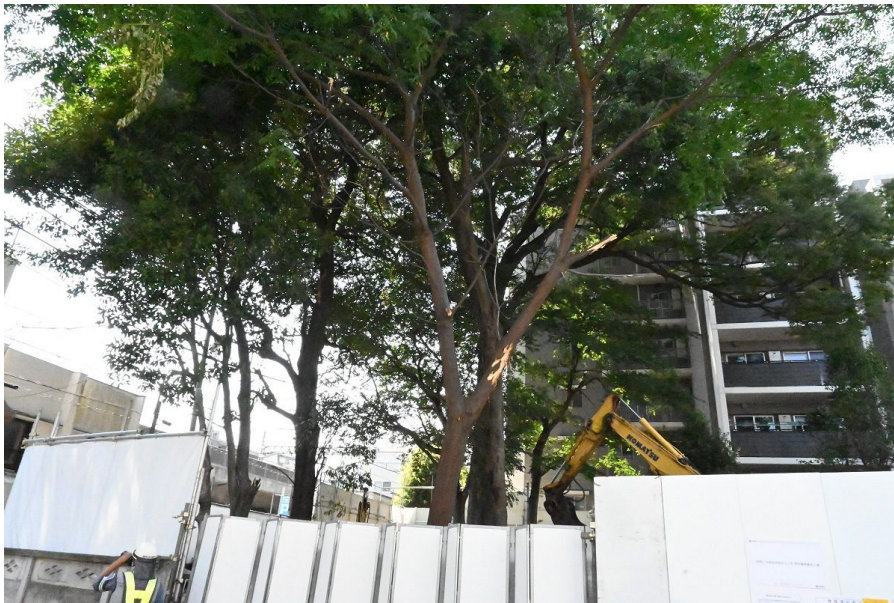
ケヤキの周囲は仮囲いができ、重機での作業が進んでいた=7月25日、東京都杉並区西荻北で
