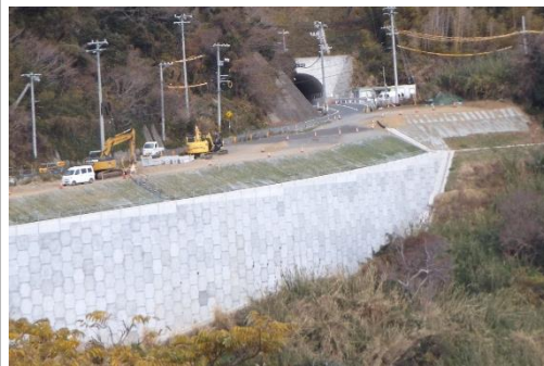
トンネル出口（四代側）
