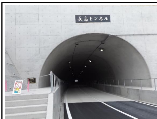
長島トンネル
