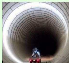
↑ 健全度調査実施状況 （走行型画像計測）
