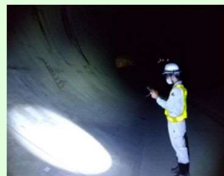
↑ 健全度調査実施状況（目視）
